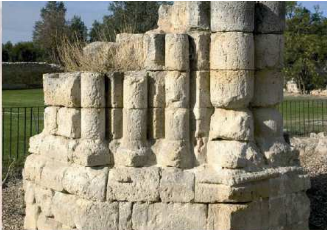
Arranque de uno de los pilares de la iglesia gótica
